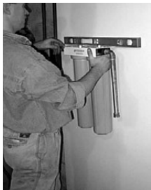
Installation der Filteranlage
